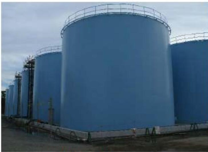
鋼製円筒型タンク(溶接)
