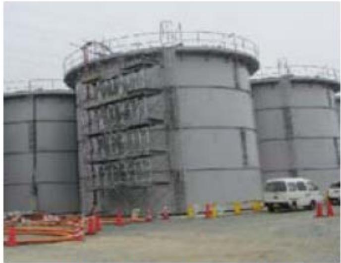
鋼製円筒型タンク(ボルト締め)
