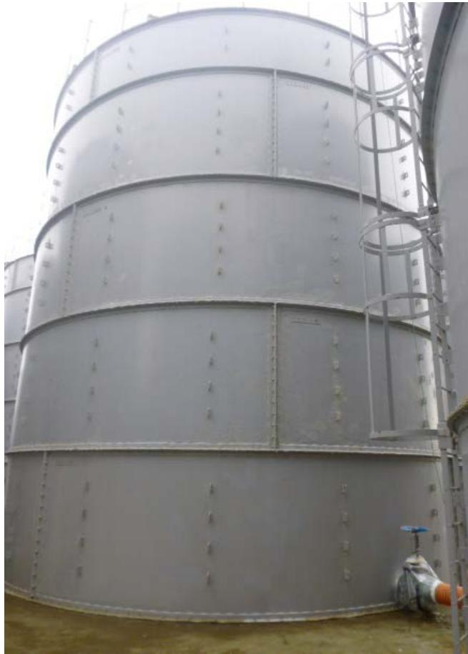
【鋼製法兰ジ型タンク】
