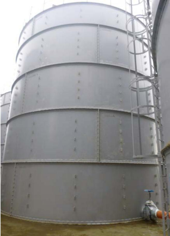
【鋼製円筒型タンク(ボルト締め)】
