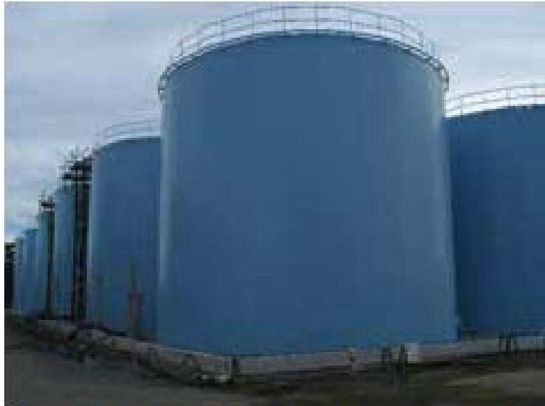
鋼製円筒型タンク（溶接）
