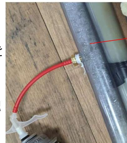
充填材がほとんど固化せず気泡ばかりになっている
