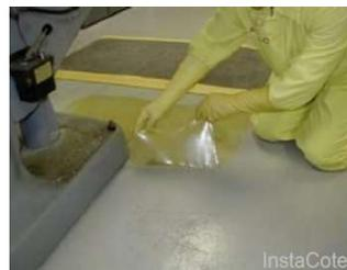
ダスト飛散抑制材
