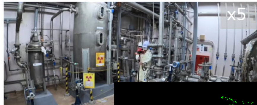
測定位置及び空間線量率の計測結果 ※空間線量率の色分布 0.0(緑色)~7.56(赤色)[mSv/h]
