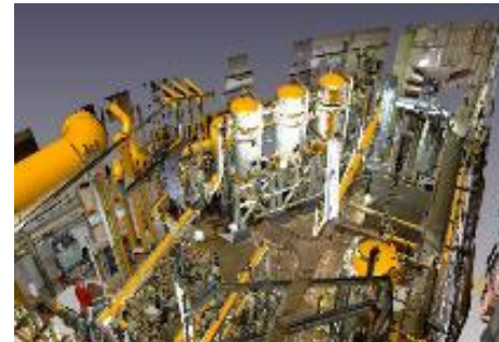
3D点群データより詳細CADデータを整備
