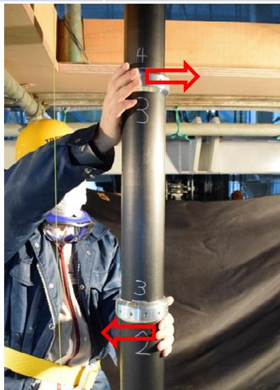
3段目パイプに曲げ方向の力をかけてガタを潰している様子
