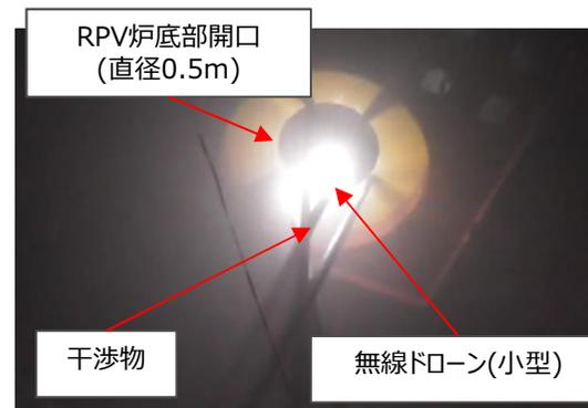
RPV炉底部開口を通過する無線ドローン(小型)
