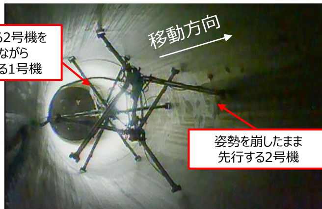
図1 先行する2号機の子輪を壁面から外した試験 （解説：2号機の子輪は壁面から外れているため、姿勢が不安定で推進力は無い。1号機が後ろから押し上げることで、垂直配管を移動している）
