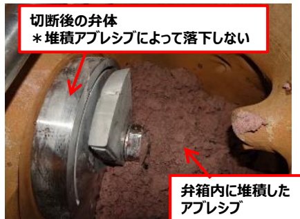
図1 弁体切り落とし後の状態 (解説：モックアップ外で弁体切り落としを実施後、モックアップ逆止弁体内に切断弁体と使用したアプレシブを戻して、弁体の弁箱内落下状態と洗浄ノズルによるアプレシブ除去性能を評価)
