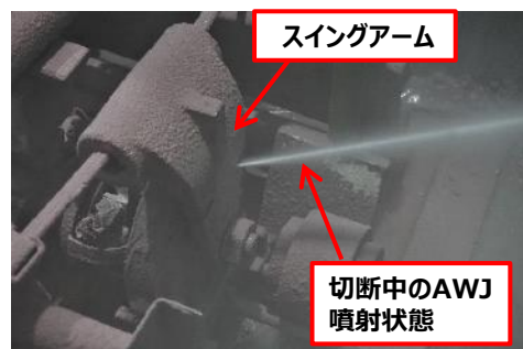
図2 弁体&スイングアームの同時切断 （解説：スイングアーム部は、AWJノズル回転速度を低下させ、弁体と同時に切断）
