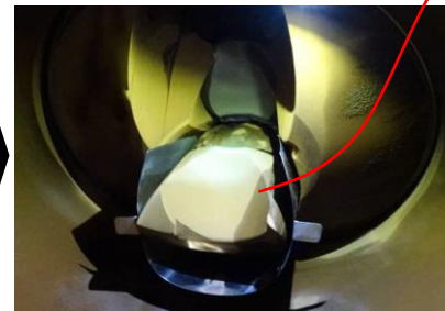
(c)コアガラキャッチャー引き抜き、コアガラを弁体から撤去 ※撤去したコアガラは、次作業に干渉しない配管内箇所に残置
