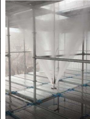
(b)鉛直降下している様子
