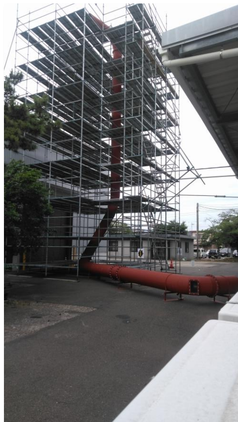
配管立ち上がり部
