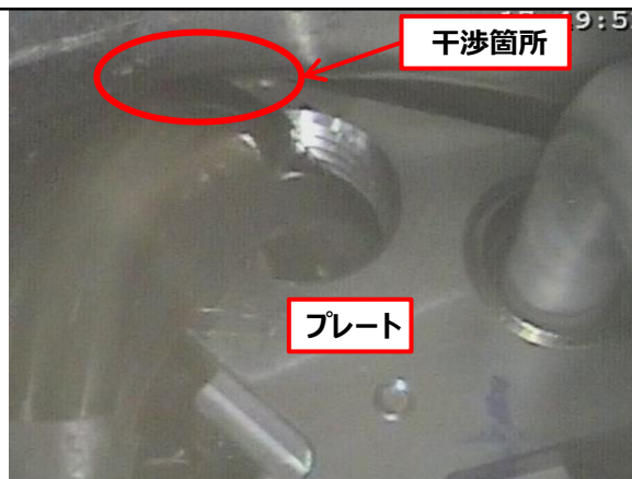
図2 クローラが配管内壁と干渉する様子 (解説：264mmの連結棒を用いたとき、図3に示す改善前フレームでは、プレートが配管内壁と干渉した)
