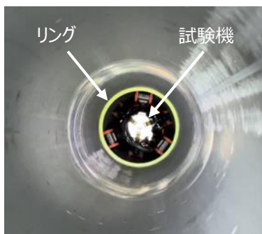
図2 配管内から見た模擬段差 (写真は5mmの段差)
