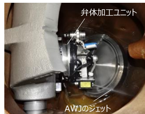
図4. 適切な姿勢になった弁体へ追加切断するための位置決めをする様子
