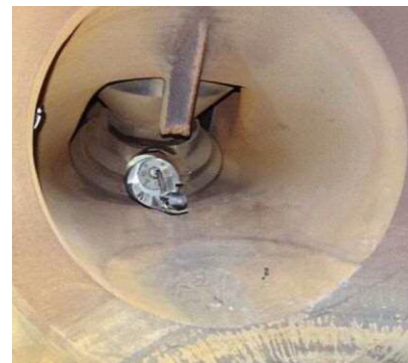
図3 外弁穿孔部の通過状況
