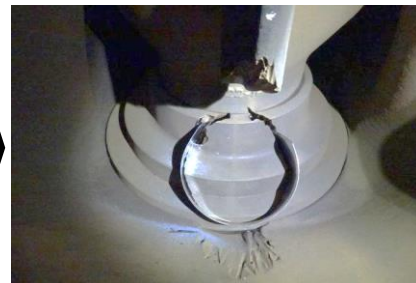
(b)切断箇所へコアガラキャッチャーを差し込み。その後、残った部分を切断し、落下したコアガラを受け止める
