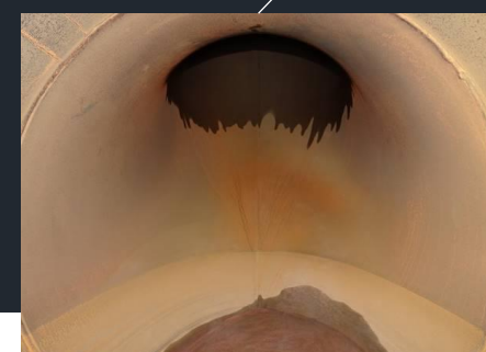
(f)穿孔完了後のPCV側エルボ内面 (解説：測定困難な目粗しを確認)
