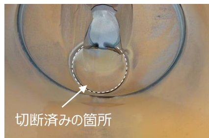
(a)穿孔途中 (解説：弁体最上部は切断しない。)
