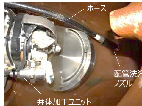
図3. 配管洗浄ノズルによるアブレシブ撤去の様子
