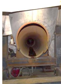
図4 見直した切断軌道によるエルボ開口部外観
