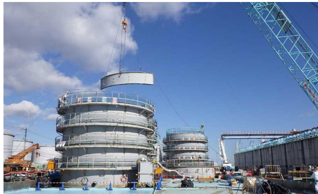
図1 タンクの解体 *3
