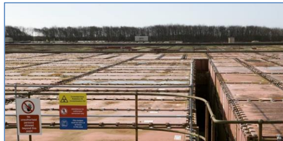
図3 LLWRにおけるLLW及びVLLWの処分(左:コンテナの外観、右:保護層構築の概念図)
