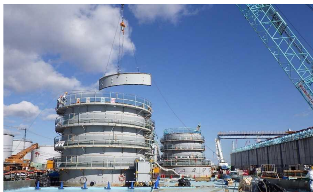
図1 タンクの解体 *3
