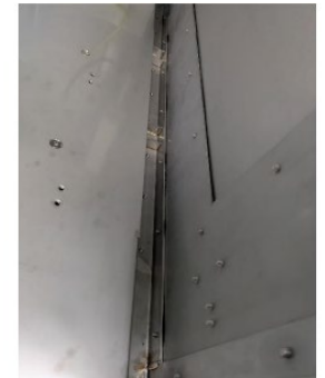
放水後の内部写真 （水の侵入なし）
