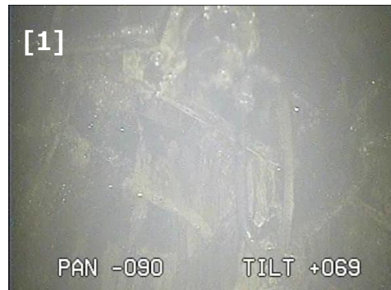
2号機CRDハウジング支持金具部（仰角69°）
