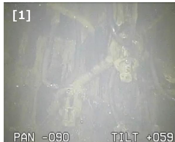
2号機CRDハウジング支持金具部（仰角59°）
