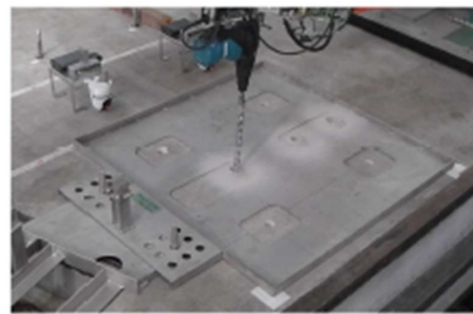
ケミカルアンカー用ベース固定用の穿孔（1）
