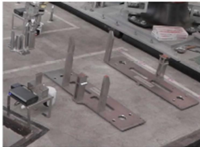
カプセル投入用のガイド設置 (1)
