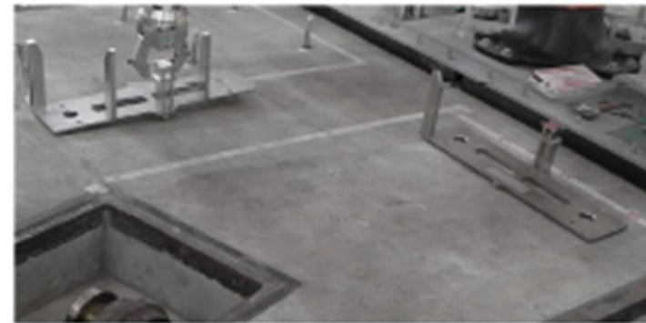
ケミカルアンカー用ベース設置 (4)
