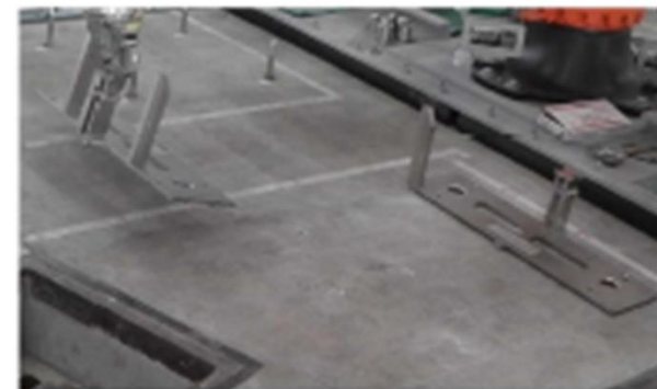
ケミカルアンカー用ベース設置 (6)
