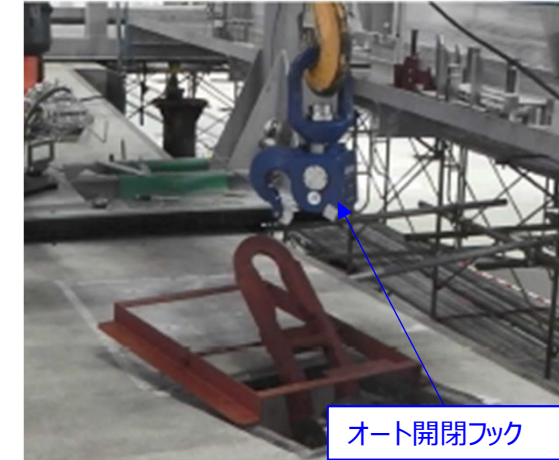
㉙オート開閉フックを専用ラグピン用フック位置まで移動
