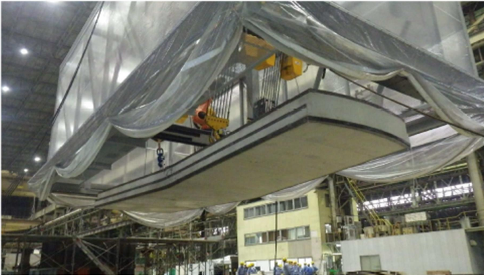
ウェルシールドプラグ吊り上げ（3/3）
