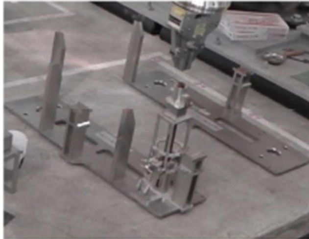
ケミカルアンカー把持部設置（4）
