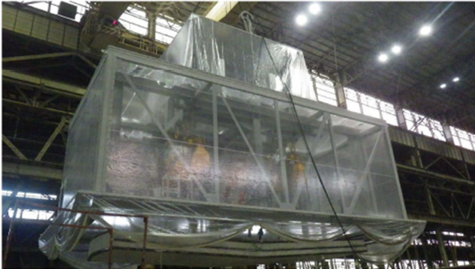
ウェルシールドプラグ吊り上げ（2/3）
