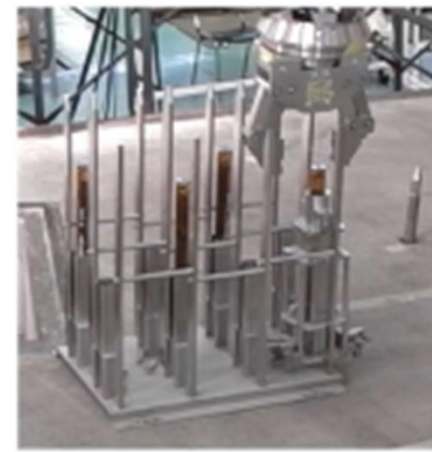
ケミカルアンカー把持部設置 (1)
