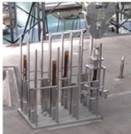
ケミカルアンカー把持部設置 (2)
