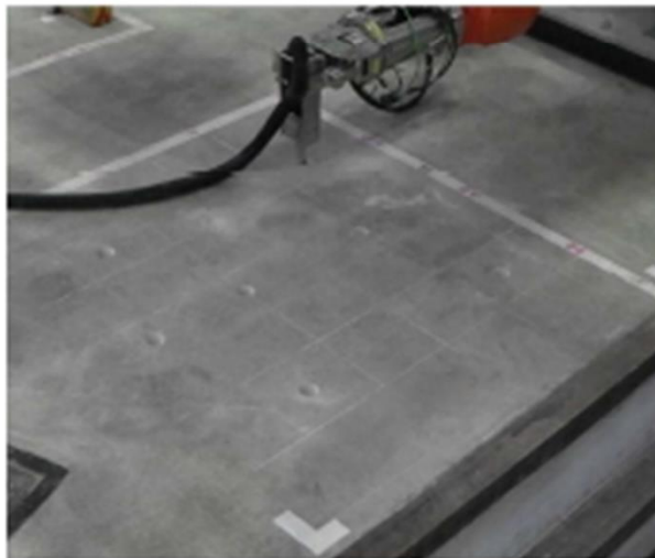
孔内清掃（吸引）（2）
