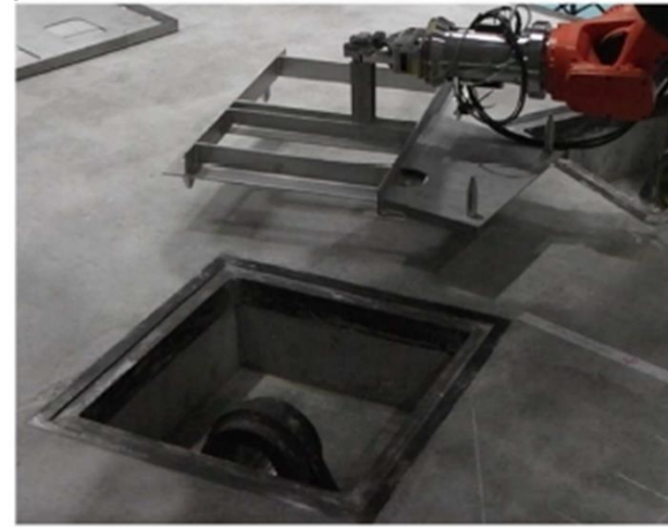
④アンカー打設用テンプレートその1をラグ位置に設置
