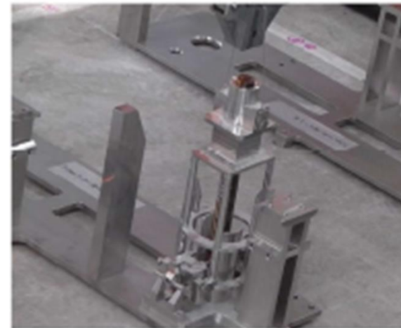
ケミカルアンカー把持部設置（5）
