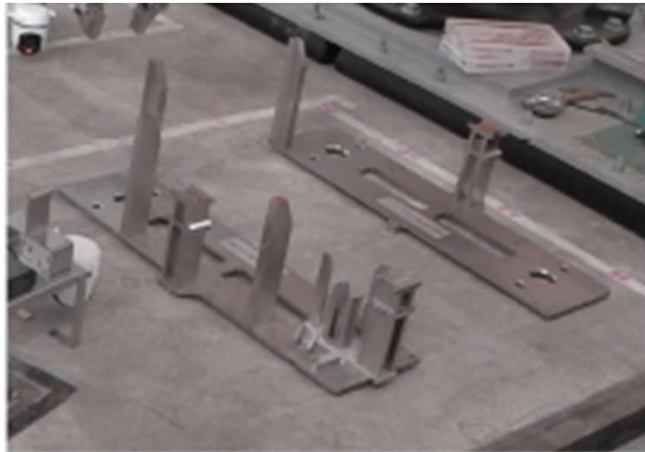
カプセル投入用のガイド設置 (3)
