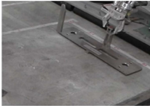
ケミカルアンカー用ベース設置 (3)
