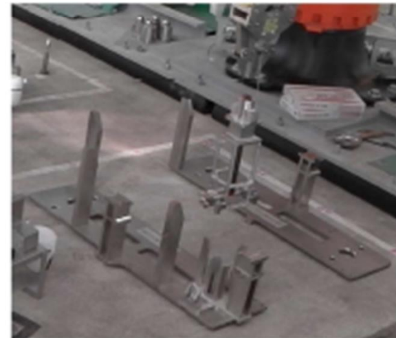
ケミカルアンカー把持部設置 (3)
