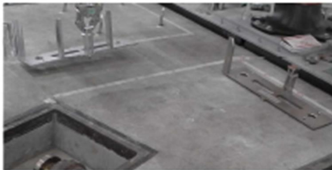
ケミカルアンカー用ベース設置 (5)
