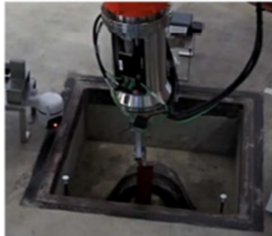
⑤脱落防止ブラケット1をラグの窪みへ設置
