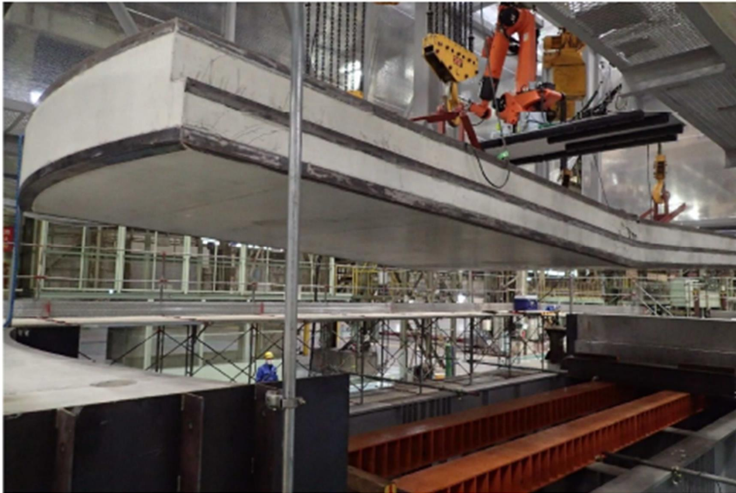
④ウェルシールドプラグ吊り上げ
