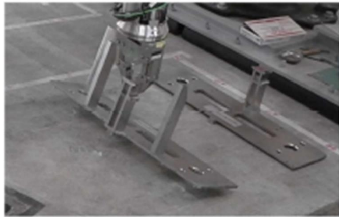
ケミカルアンカー用ベース設置 (7)
