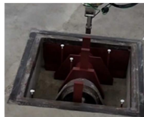
⑮脱落防止ブラケット2をラグの窪みへ設置
