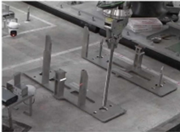
アンカーボルト打設 (1)
