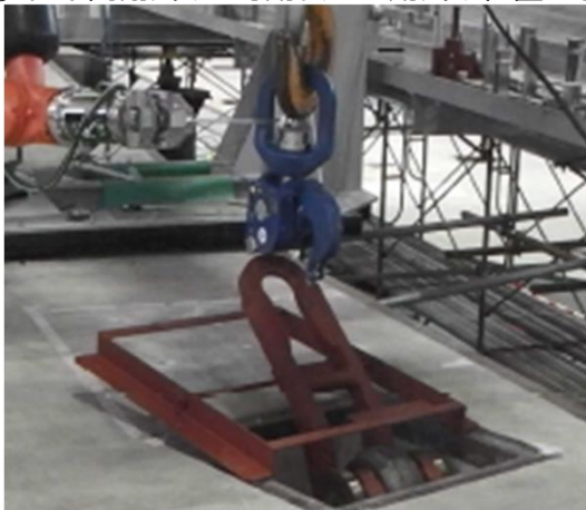
㉚オート開閉フックを専用ラグピン用フック位置まで移動
