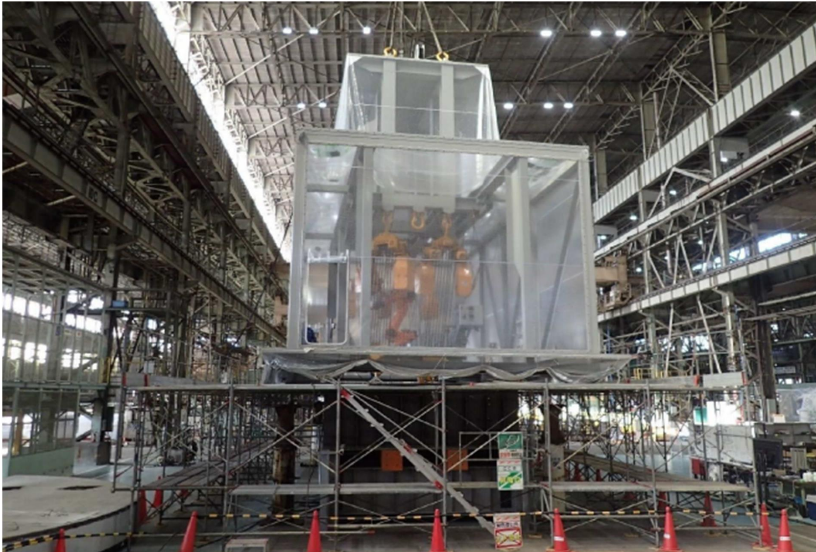
ウェルシールドプラグ吊り上げ
